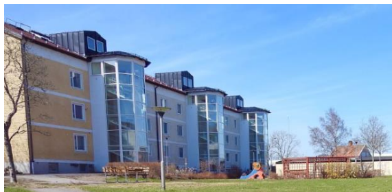
Hissinstallation på Älgerumsvägen 22
